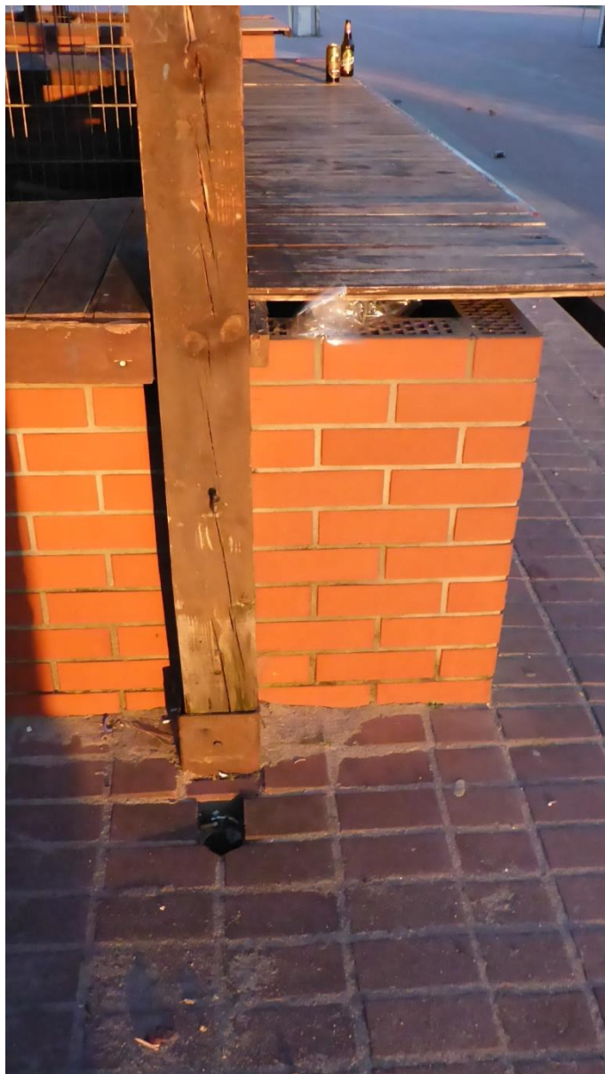
Zdjęcie 9 Oparcie konstr. drewnianej na fundamencie
