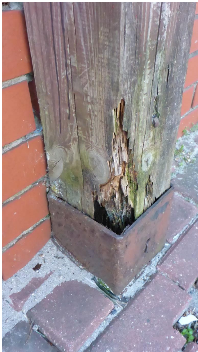
Zdjęcie 15 Ubytki słupa przy podstawie
