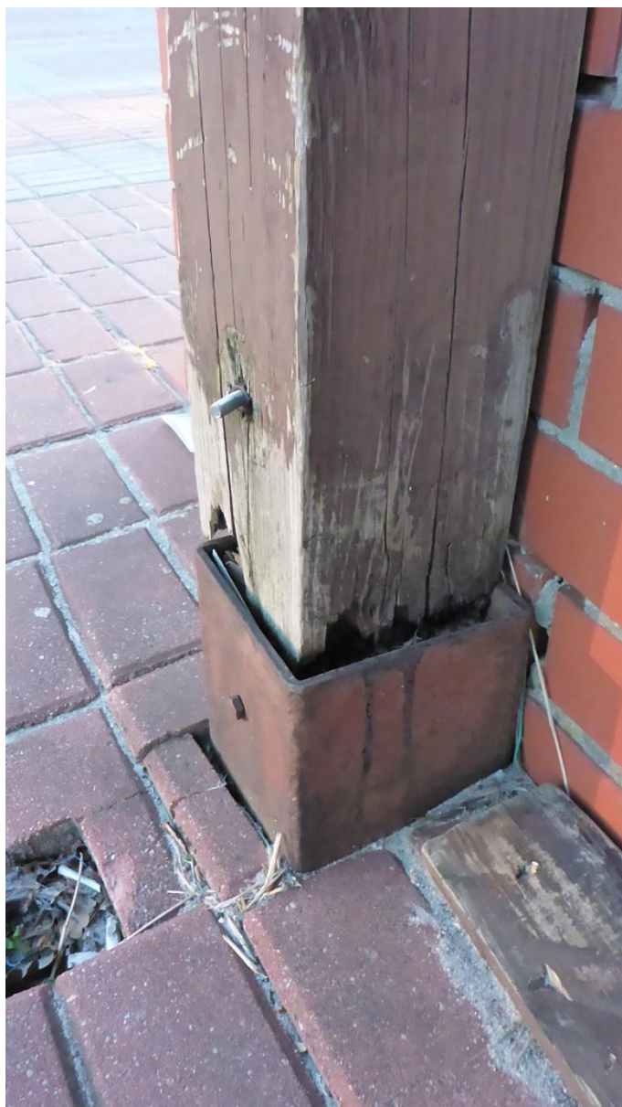
Zdjęcie 14 Zamocowanie słupa na fundamencie
